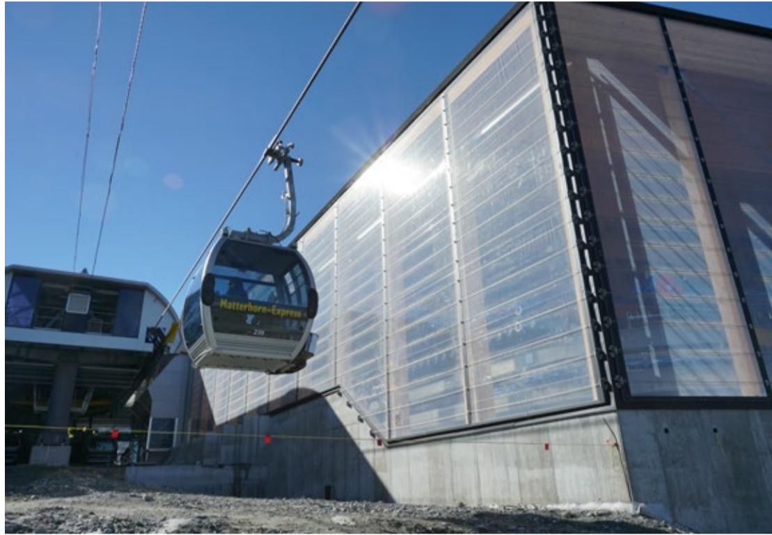
Transparente Spezialfolie auf Aluminiumprofilen // Bildrecht: HP. Gasser AG
