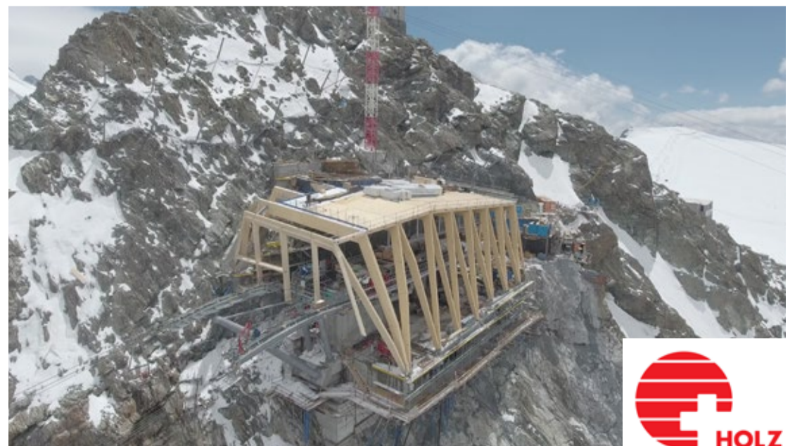
Primärtragwerk auf dem kleinen Matterhorn // Bildrecht: Zermatt Bergbahnen
